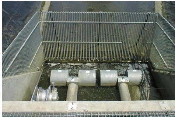
Exemple d'ouvrage de régulation de débit
