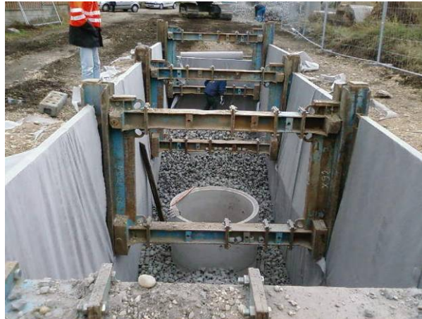
Exemple de bassin enterré en cours de réalisation
