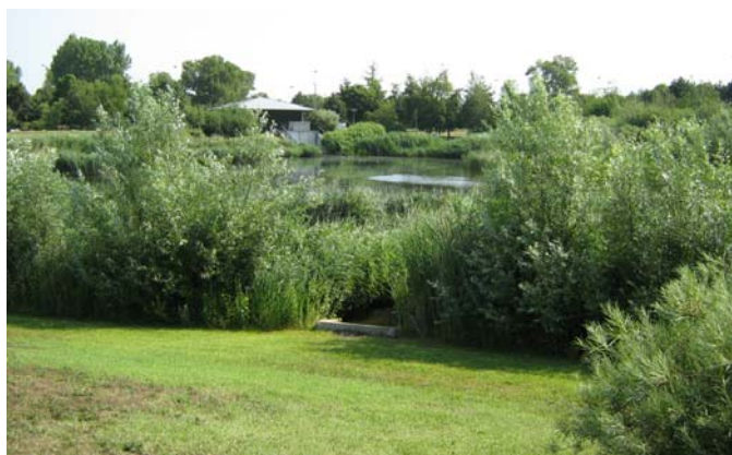
Bassin paysager en eau talus 6/1- Porte de Alpes/Grand Lyon
