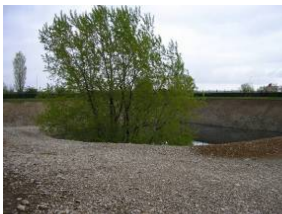
Bassin d'infiltration après une pluie
