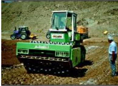
Compactage idéal pour les matériaux argileux : le pied de mouton
