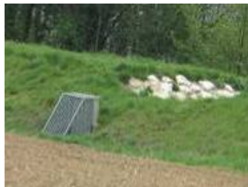
Déversoir en enrochements bétonnés sur bassin agricole
