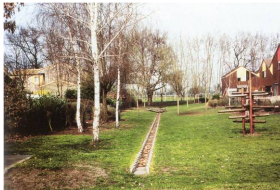
Noue en béton Bruges (33)
