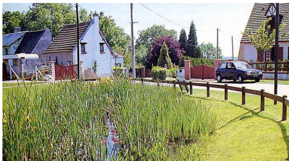
Fossé de rétention
